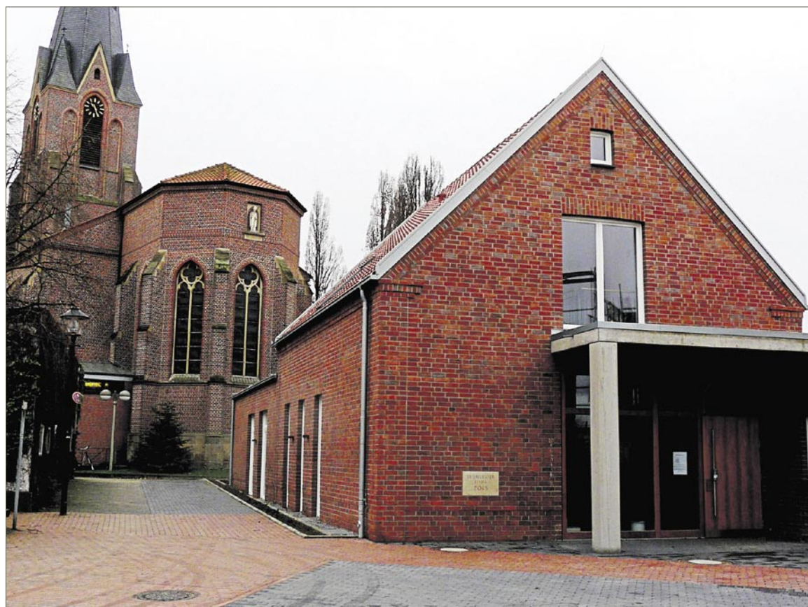
Nach einem Jahr Bauzeit fertig gestellt: Das St.-Silvester-Haus in Erle.
